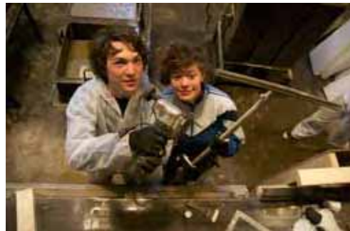
Studenter ur ateljé Y arbetar med betong våren 2007. Foto Hannes Karlsson
