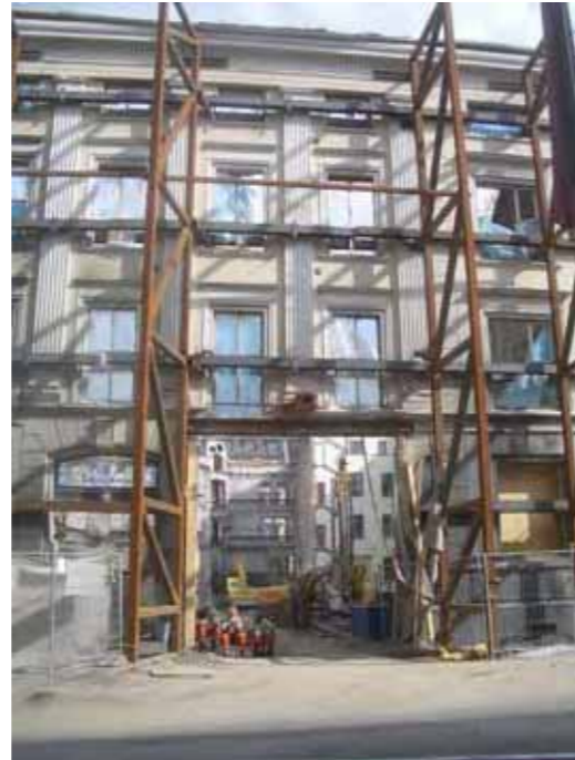
Fasad i väntan på nytt innandöme i Oslo.
