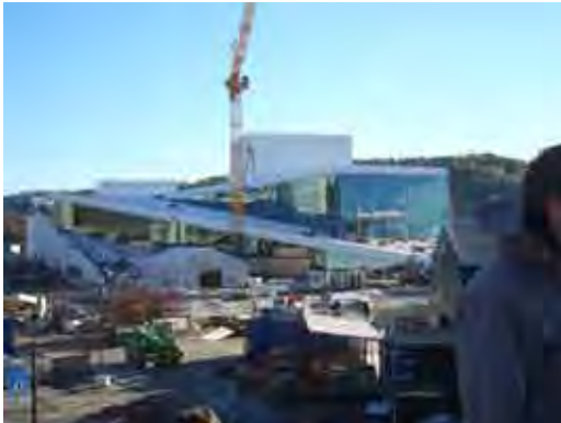
På studiebesök i Oslo vid det pågående operabygget.
